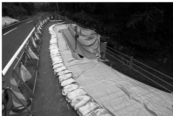
▲川崎地区道路崩落現場
