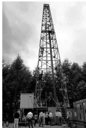
▲まっかり温泉3号井掘削現場
