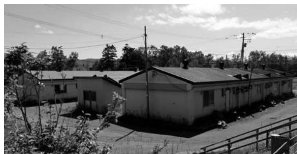
▲解体が1年先送りになった見晴団地（一部）
