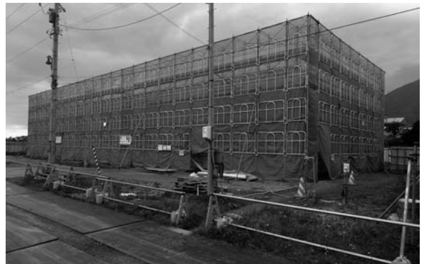
▲建設中の公営住宅
