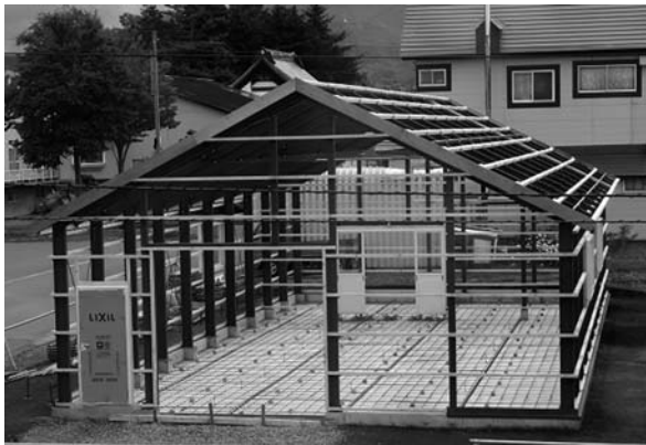
▲防災用資機材倉庫建設中 (6月21日 役場東側)
